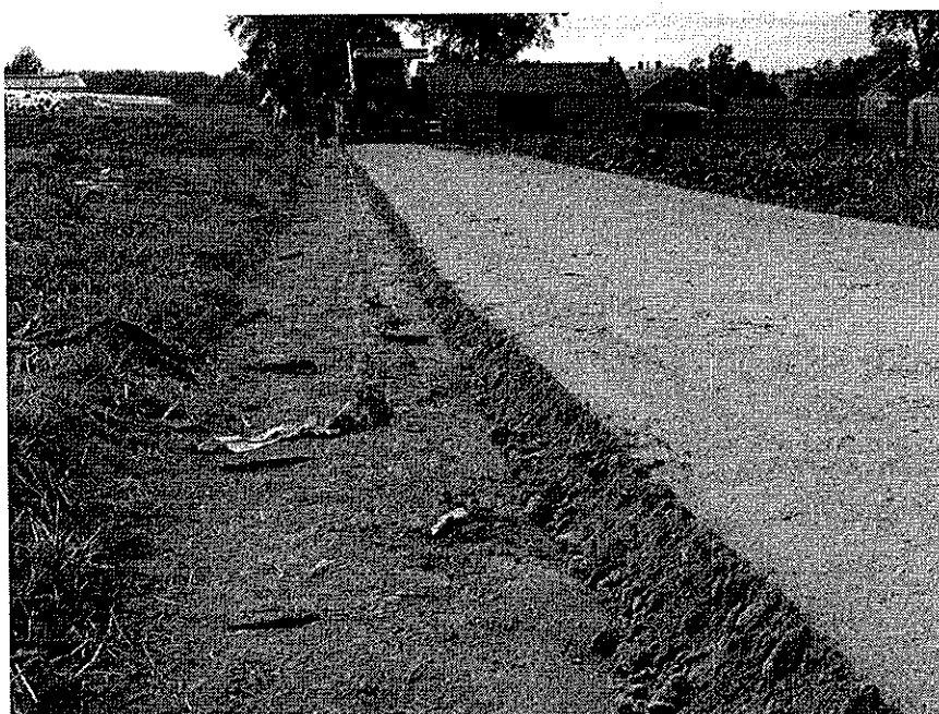
Modernizacja drogi nr 110330C w miejscowości Radomin
