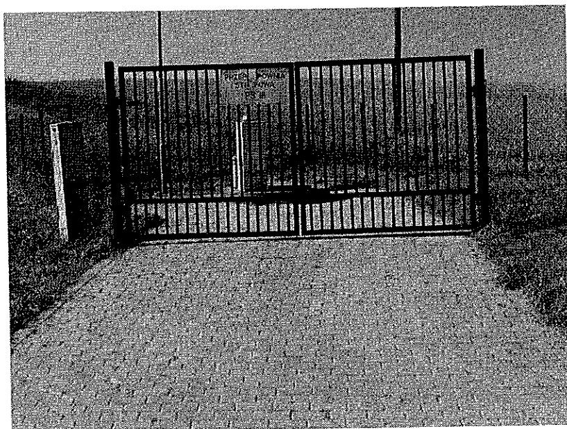
Przepompownia ścieków PS3 w Piórkowie
