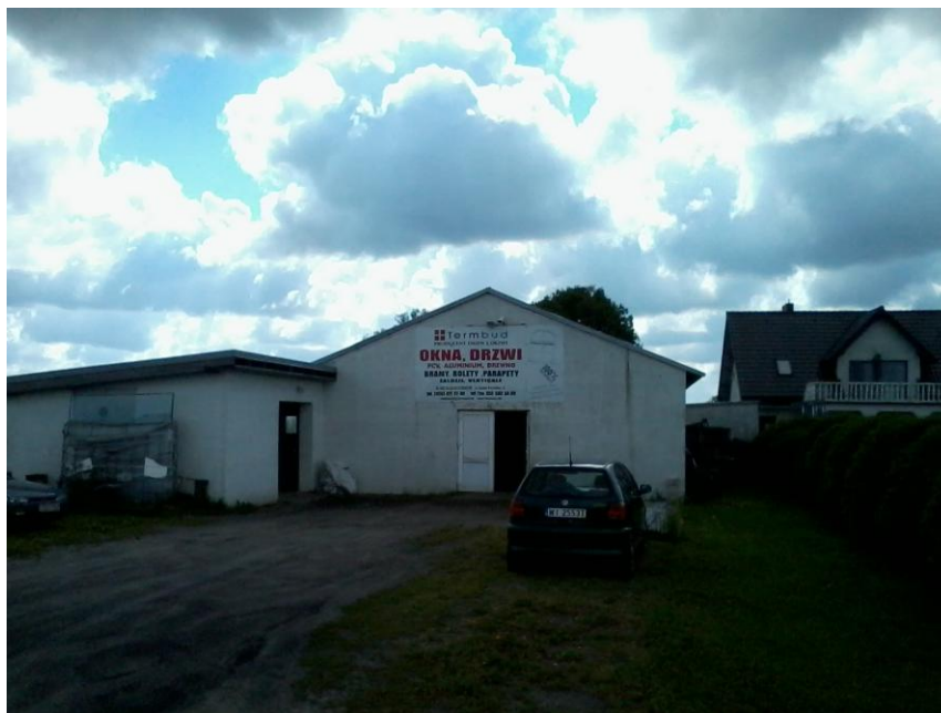
Rys. 15. Zakład produkcji okien i drzwi.
